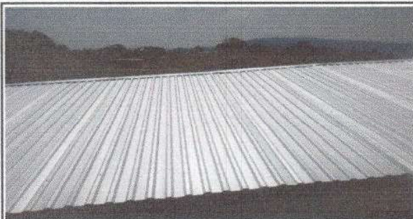
Foto 1: Área donde se realizó el cambio de techo de lamina
