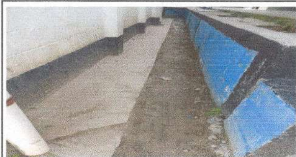
Foto 5: Área donde se realizó la reparación del muro de block
