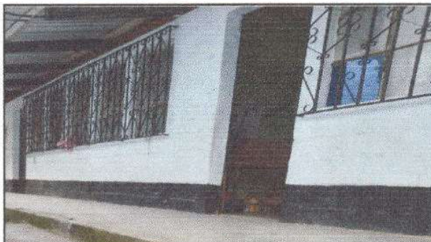
Foto 4: Sustitución del vidrio del aula de primer grado
