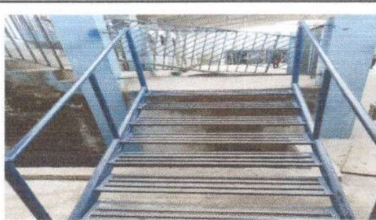
Foto 6: Área donde se realizó la reparación de baranda de metal
